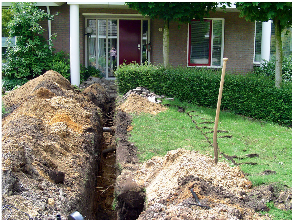
Figuur 8.2 Afkoppelen regenwater van een woning.
