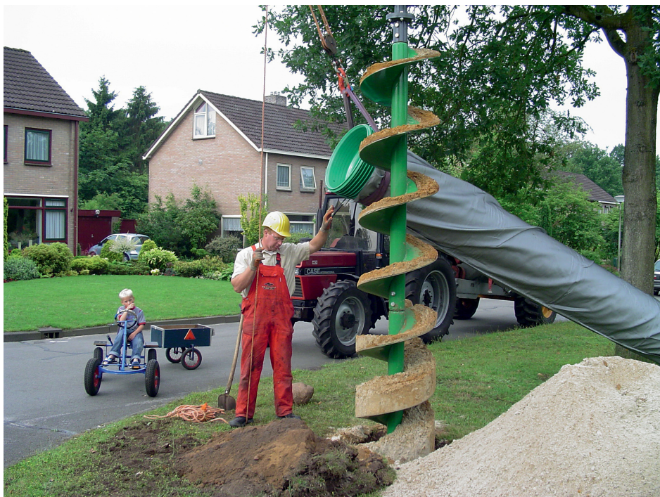
Figuur 8.3 Het boren van gaten voor de verticale infiltratie-units.
